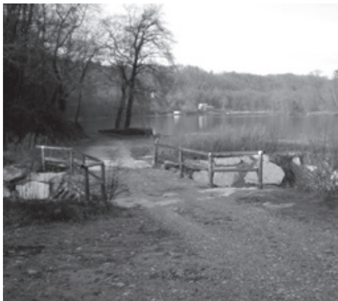
Ponticello in Via Panoramica - località Linosa
