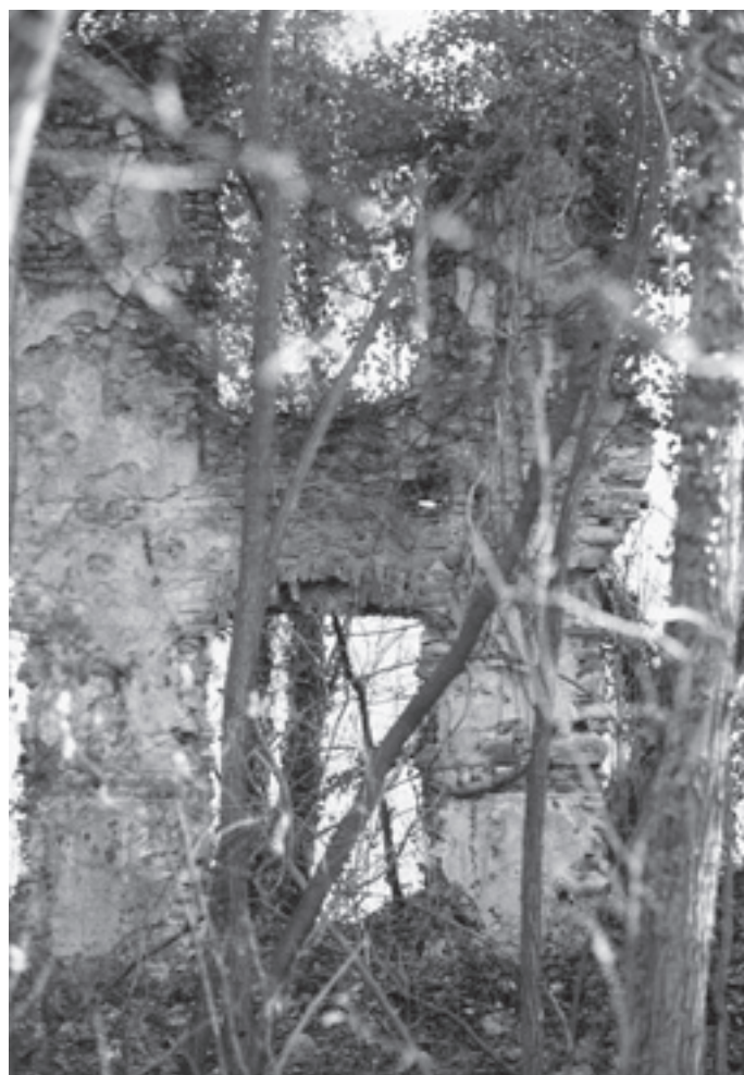
Resti del Mulino delle due Comunità muratura in ciottoli e laterizi. Archivio Carlo Mazzella.
