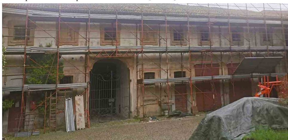
Il cantiere di Villa Soranzo
