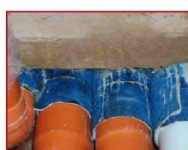
Particolari costruttivi all'interno di un cavedio (curva con gomiti a 45° in alto a sinistra, guaine isolanti al passaggio di muri e solette in basso a sinistra, fissaggio tubi con collari antivibranti a destra)
